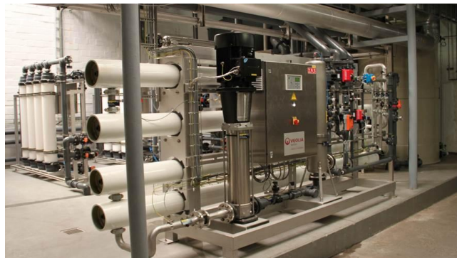
Erzeugt Permeat ähnlich der Qualität von demineralisiertem Wassern: Umkehrosmose Sirion mega
