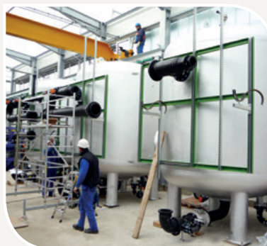
Pünktliche Projektrealisierung durch termingerechten Einbau der Ionenaustauscher
