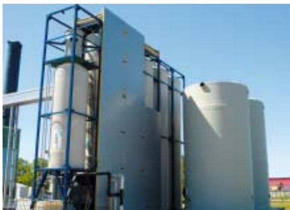
**Bild 5.** Modulare EGSB Anlage bei der Inbetriebnahme in der Cesu Alus Brauerei, Lettland.
