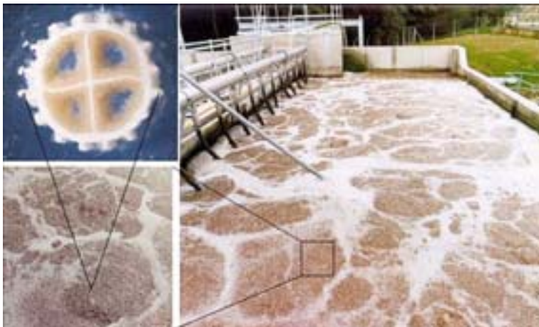
Bild 3: Das Moving-Bed-Biofilm-Reaktor (MBBR)-System
