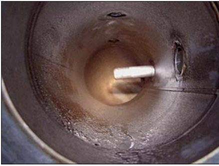
Ein Edelstahlrohr aus dem Eiswasserkühler der Bitburger Brauerei vor und nach der Reinigung mit der VWS MOL CLEAN-Katalysator-Technologie. Die Brauerei nutzt das Verfahren seit 2006 regelmäßig zur Biofilmbeseitigung.
