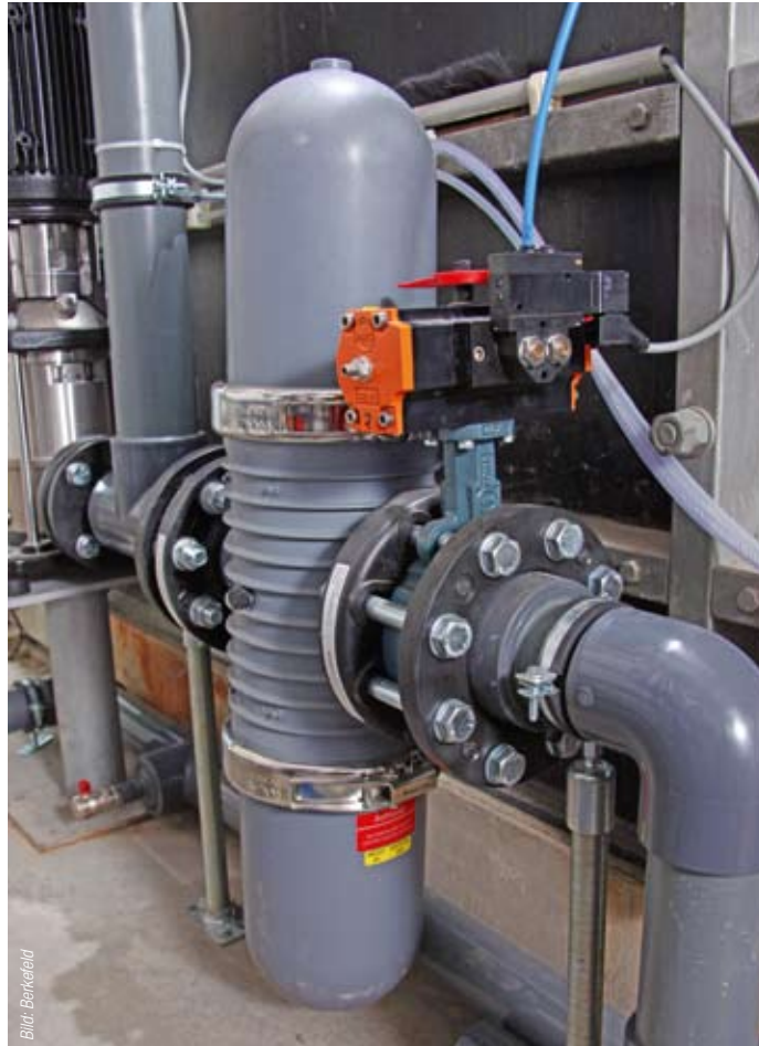
Bild 1 Der doppelte Berkal Disk-Filter schützt die Ultrafiltration vor Schwebstoffen.
