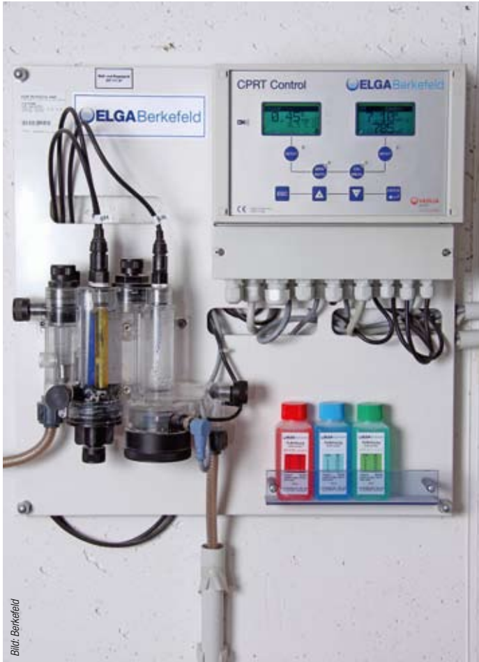
Bild 4 Die Mess- und Regelungseinheit CPRT 4044 misst, dokumentiert und regelt pH-Wert und Chlorgehalt.
