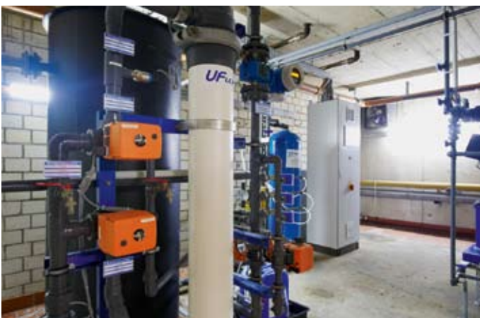
■ Ultrafiltration bietet sich besonders zur Aufbereitung von Becken- und Spülwasser in Schwimmbädern an.
